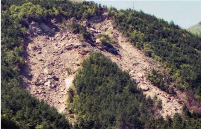
被災状況：栗輪谷区域山腹
