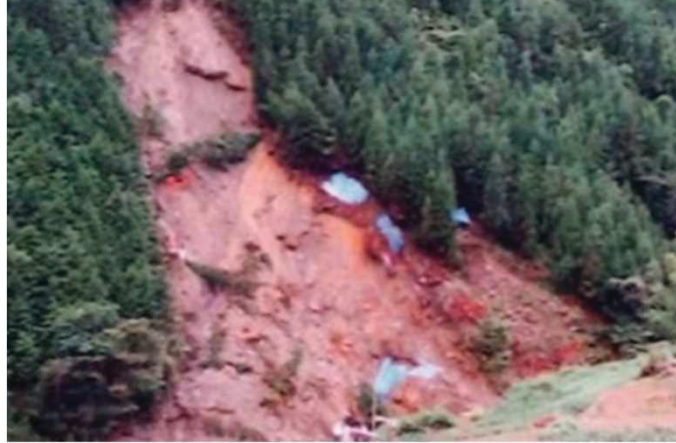
被災状況：岩の谷区域山腹
