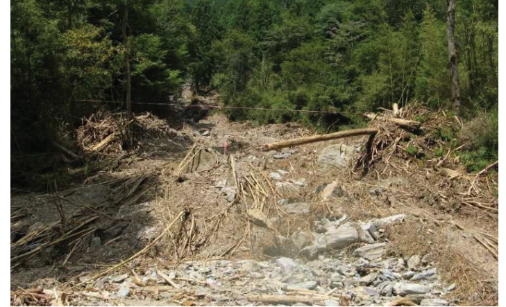
被災状況：一の谷区域内溪流
