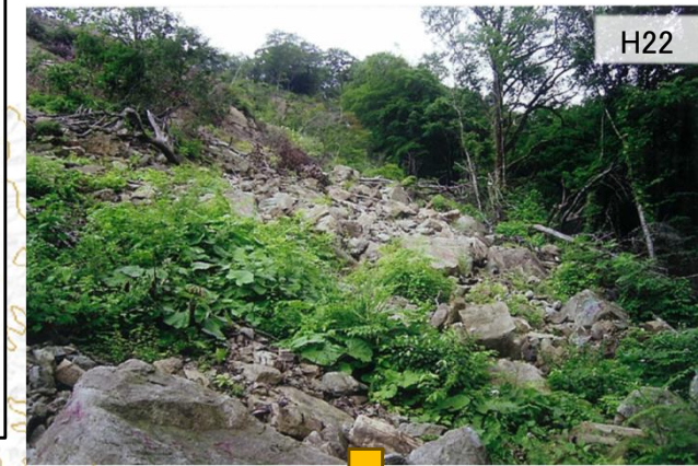
【②真湯 復旧状況】
