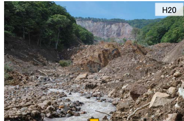
【①産女川上流 溪間工整備状況】
