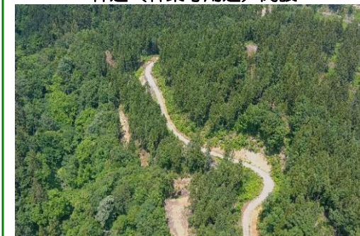
林道（林業専用道）開設
