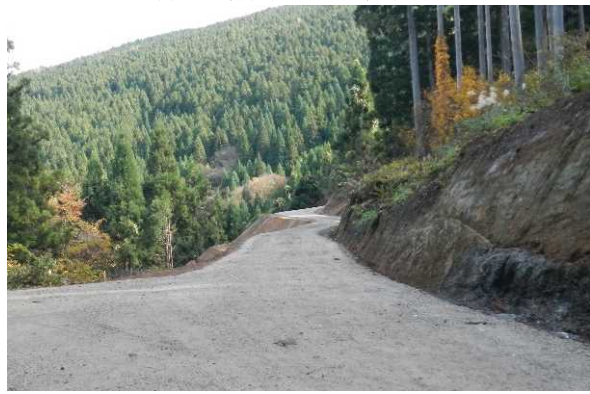
林道 (林業専用道) 開設
