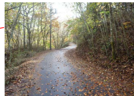
都沢林道改良工事 国有林
