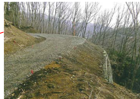
三の沢林道新設工事 唐沢国有林
