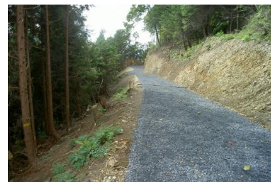
路網開設（西ノ沢林業専用道）
