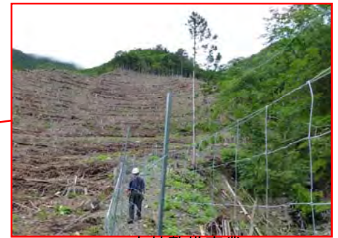
森林整備事業 (植付と獣害防護柵設置作業)
