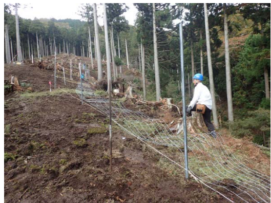
獣害防護柵設置作業
