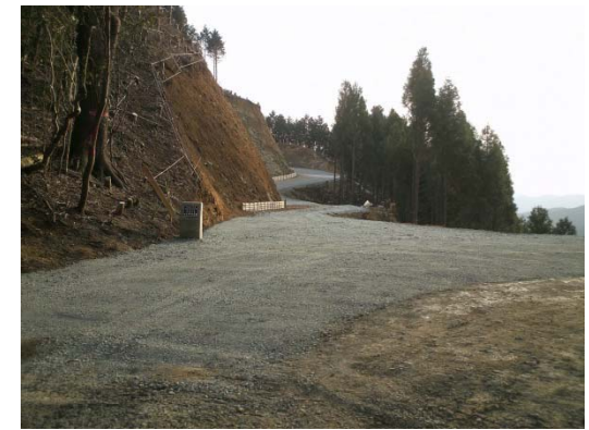
林業専用道新設工事
