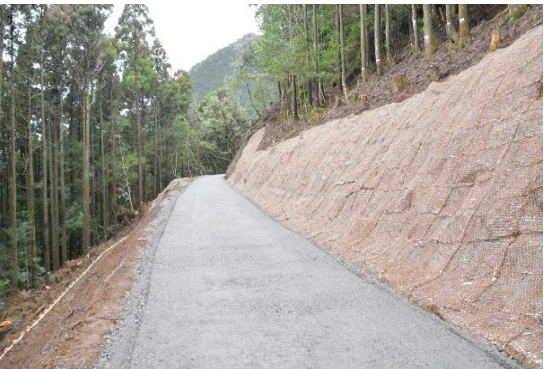
路網開設（滑沢支線林業専用道）
