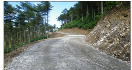
平成29年度 南信森林管理署 兀嶽林業専用道新設工事
