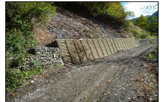
北信森林管理署 檜俣川 改良工事
