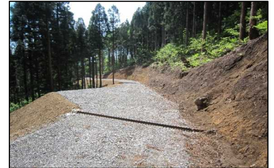
北信森林管理署 湯の入種池 新設工事
