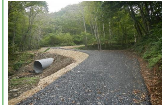
林道（林業専用道）開設
