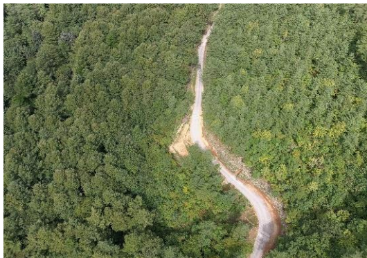
林道（林業専用道）開設
