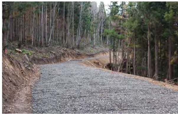
林道（林業専用道）開設
