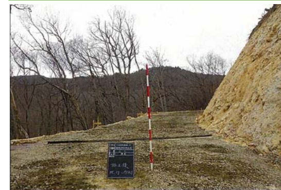
路網開設（水引林業専用道）
