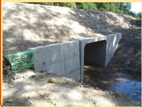
林道改良工事
