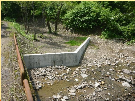
林道改良工事
