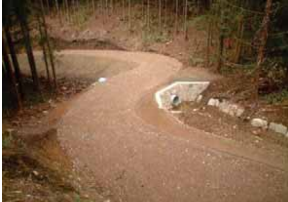
鈍引沢林道新設
