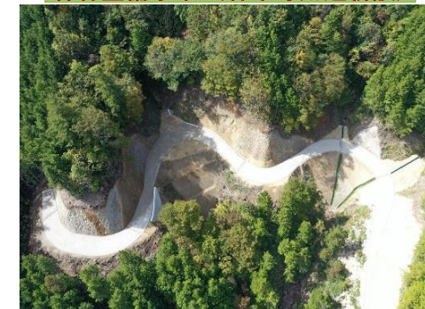
クラミ谷大洞林業専用道新設工事 (川上国有林 下呂市)
