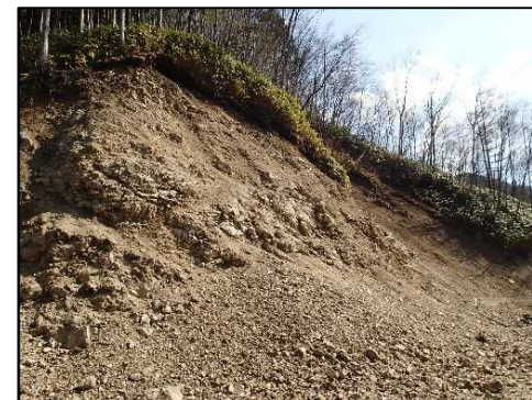
路網整備事業 (林道改良工事)
