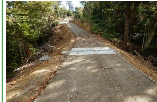
林道（林業専用道）開設
