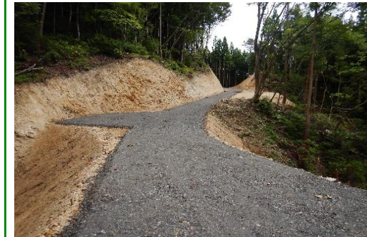
林道（林業専用道）開設
