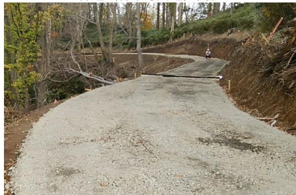
林道（林業専用道）開設
