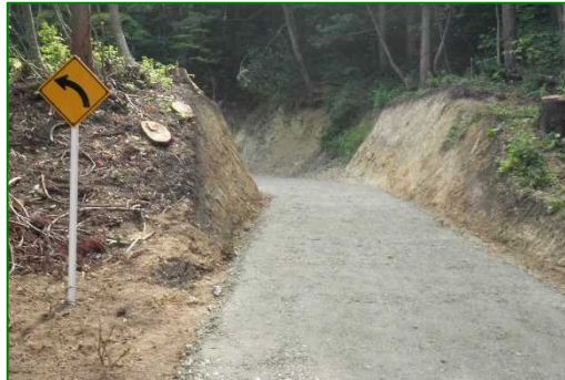
林道（林業専用道）新設
