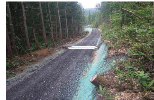
中天間館国有林（スミヤキ沢林業専用道）
