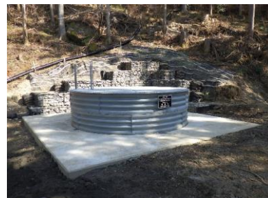
⑦ 抑制工(集水井)の実施状況
