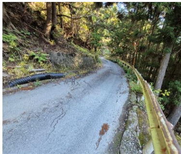
①保全対象(林道)
