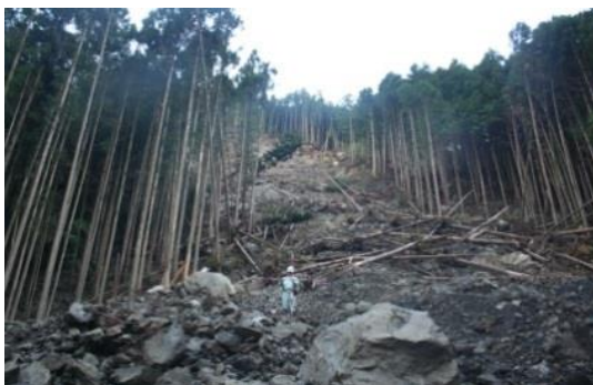
④ 山腹崩壊状況
