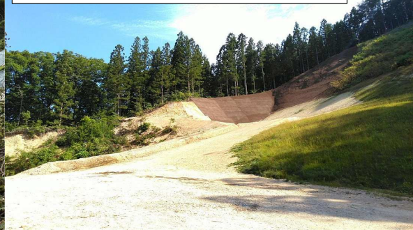
②対策工実施状況:頭部排土工(令和6年度施工)
