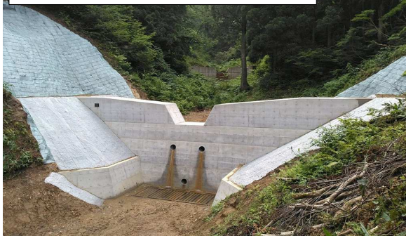
①対策工実施状況:谷止工(令和7年度施工)
