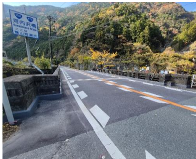
②保全対象(国道152号)
