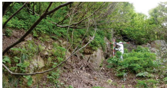
② 頭部滑落崖に連続する開口亀裂
