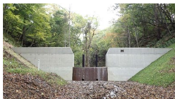
流木捕捉式治山ダムの設置
