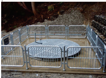
集水井工設置状況
