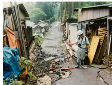
③ 被災状況
