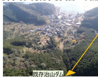
既存治山ダム
