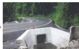
排水工の設置
