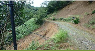
被災した森林作業道の復旧
