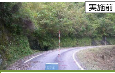
災害に備えた林道の改良
