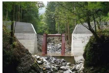
流木捕捉式治山ダムの整備
