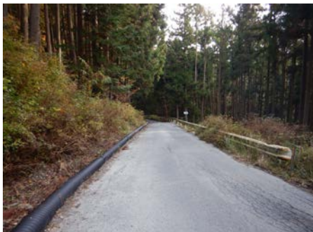
①保全対象(林道瀬尻線)
