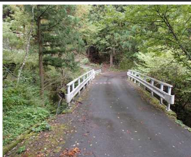
②保全対象(国道439号線)
