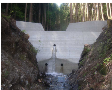
④治山ダムの設置状況(H29施工)
