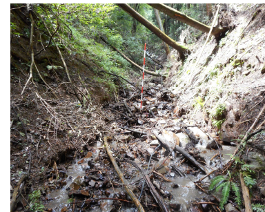
⑥H30.7豪雨による荒廃状況
