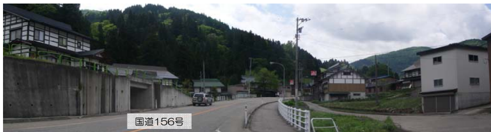
③ 保全対象（東中江集落、国道156号）
