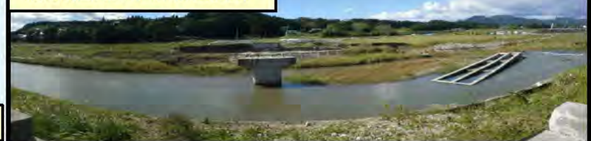
防災林造成区域（下井出地区）
