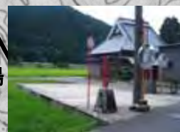
防火水槽 広瀬地区
