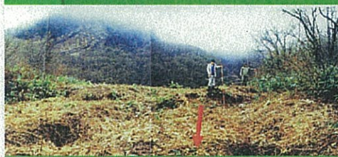
Aブロック 地すべりにより発生した段差
