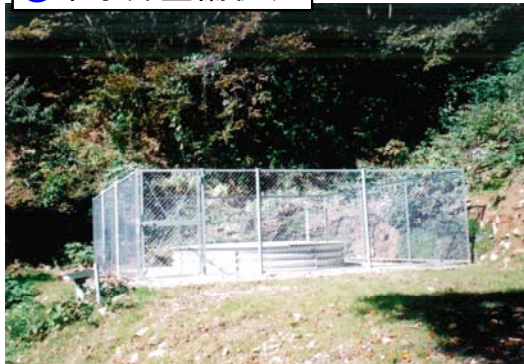
③集水井整備状況
