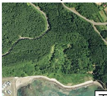
事業の完了により復旧した現地の状況
