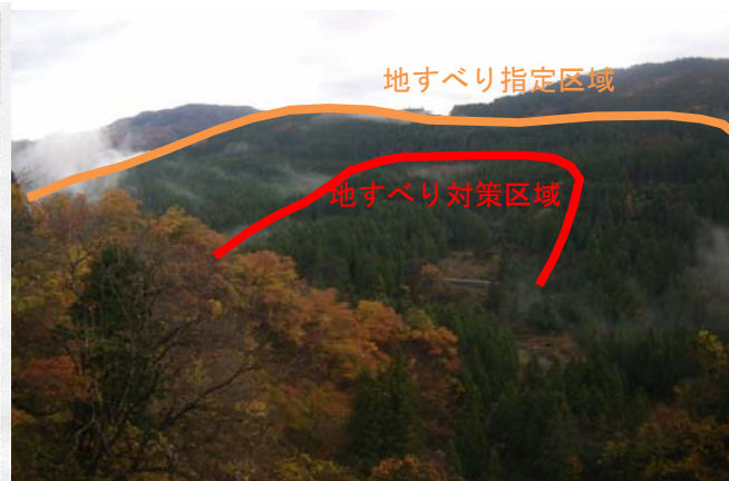
①地すべり対策区域全景
