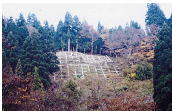
②アンカー工完了状況
