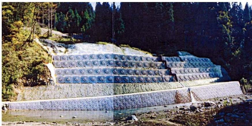
③平成14年度治山施設災害復旧事業により施工したアンカー工と土留工
