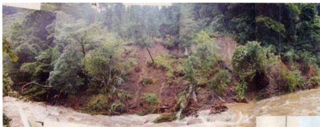
①平成14年7月の台風により地すべり発生状況
