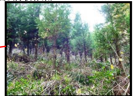
森林整備状況(除伐作業)
