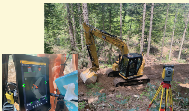
MCバックホウによる掘削・法面整形作業
