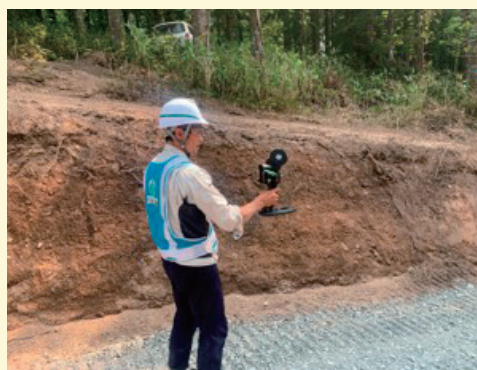
ハンドスキャナによる出来形管理
