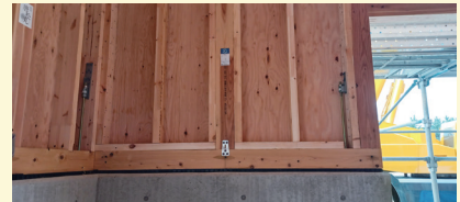
住宅用の建築金物のみで補強
