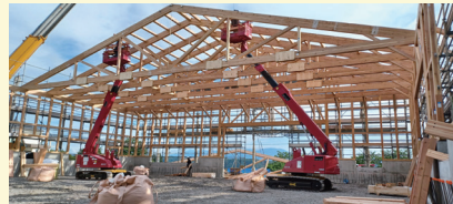
建設中の様子
