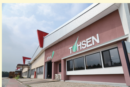
デカレ矢板の製材工場
