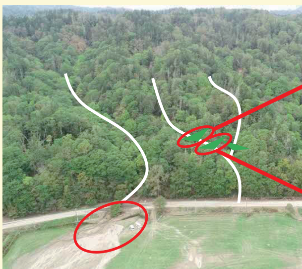
未対策溪流で下流に土砂が流出している様子
