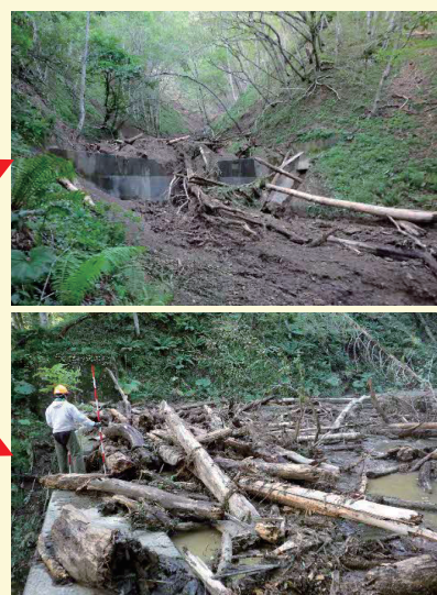
治山ダムによる土砂等の流出抑制効果
