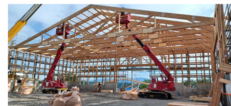
建設中の様子
