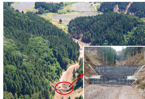
設置された治山ダム(2025年11月) (輪島市興徳寺区域)
