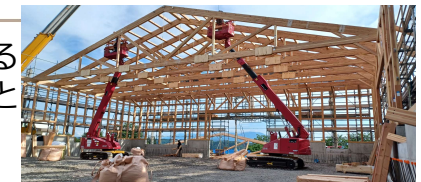
建設中の様子
