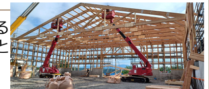
建設中の様子
