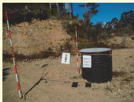
設置後の状況
