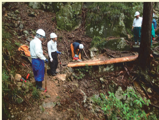
丸太橋架替えの様子
