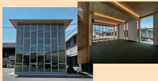
ウッドテクノス新社屋 (高知県高知市、令和6(2024)年5月竣工) GIR接合の1方向ラーメンにより開放的な空間を実現した、ヒノキ集成材を用いた低層木造ビル
