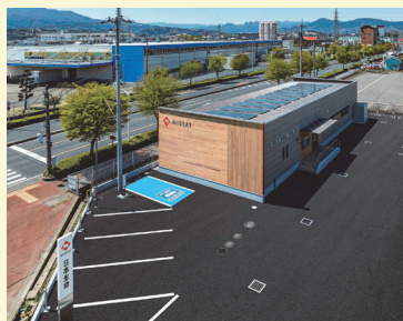
新築された営業拠点の外観
