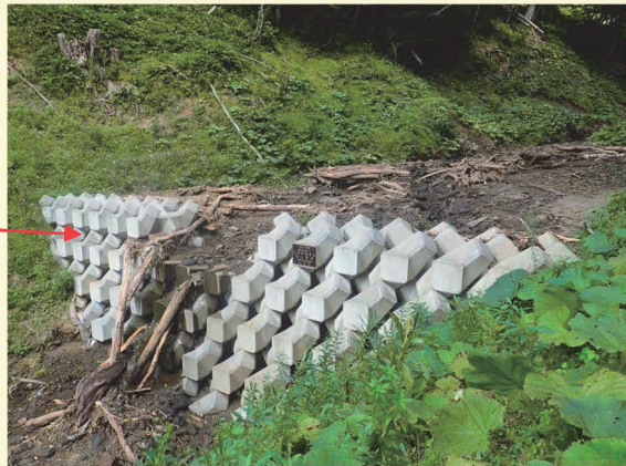
令和2(2020)年度に完成した 治山ダムによる土砂等の流出抑制効果
